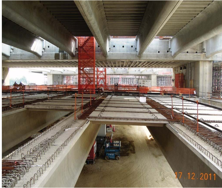
Photo 13 : Semi-precast beams
