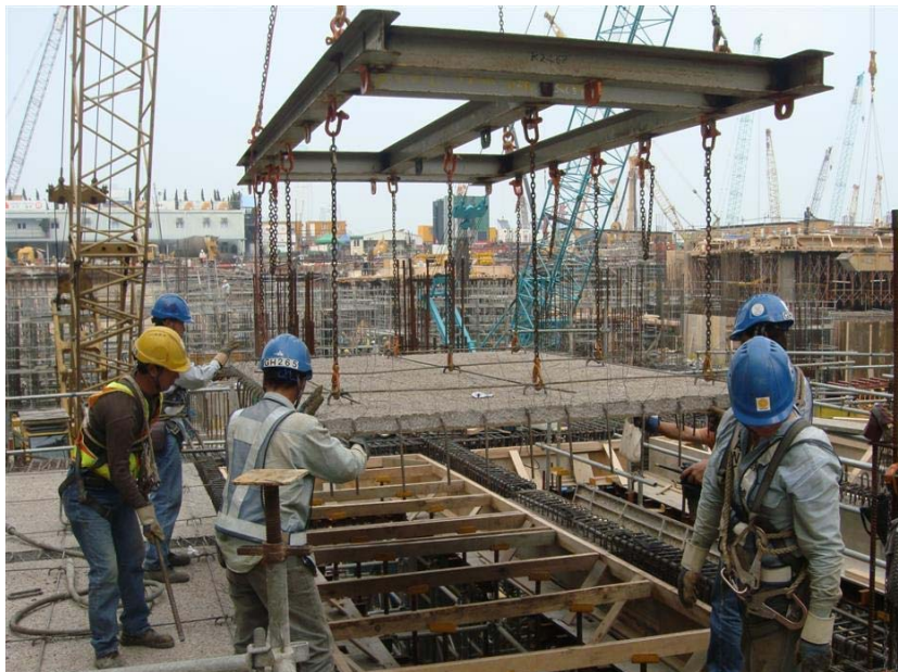
Photo 14 : Semi-precast slabs
