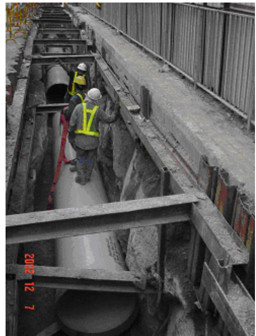
圖 1：沿富美街敷設直徑 1,000 毫米的食水幹管
