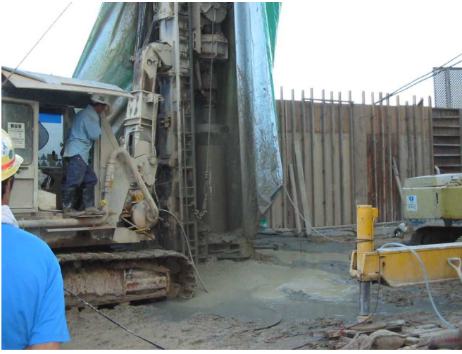
圖 3：在現有大環海水抽水站石提旁進行鎖樁工程，以興建電解產氯室
