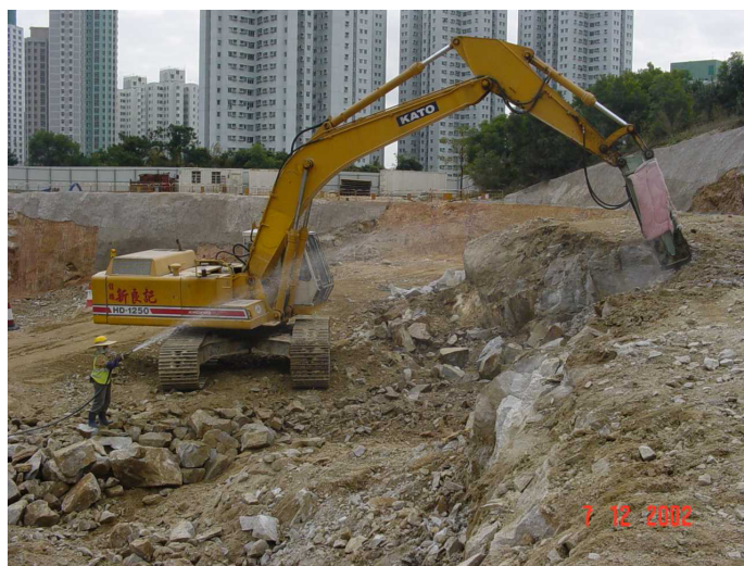
圖 2：在主水平基準以上 74 米處進行挖石工程，以建造鑽石山二號食水配水庫的地基平台
