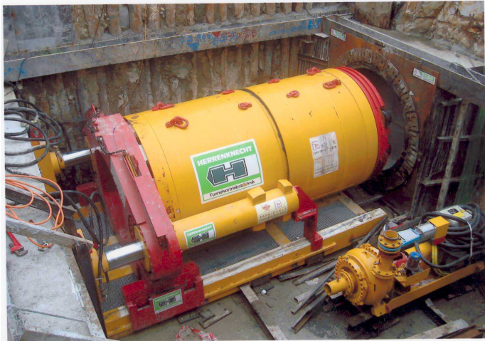
圖 4：隧道鑽挖機
