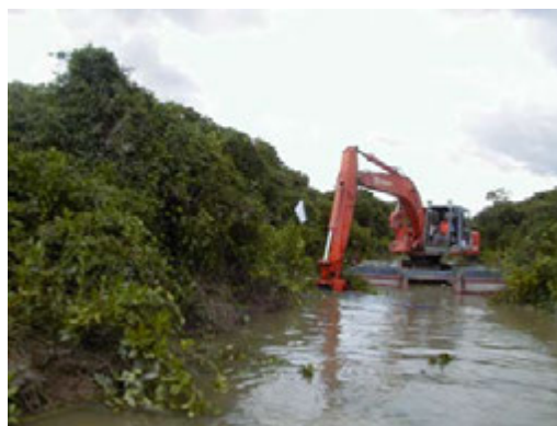
Dredging in Progress 挖掘工作進行中
