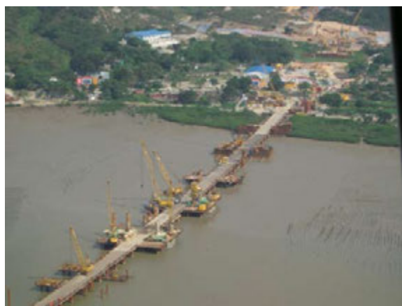
Marine piling using temporary access bridge 在臨時橋上進行海上鑽孔樁工程
