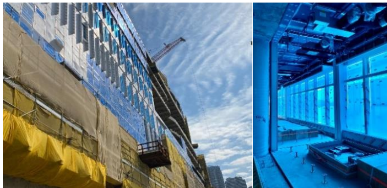
數碼港第五期採用「組裝合成」建築法
