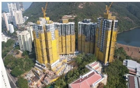
薄扶林道142號西高山發展項目
