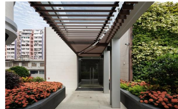
三樓有蓋行人道上附設於建築物的光伏板
