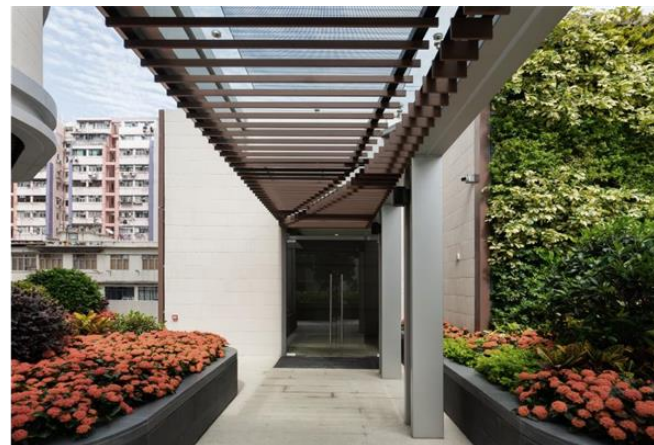
三樓有蓋行人道上附設於建築物的光伏板
