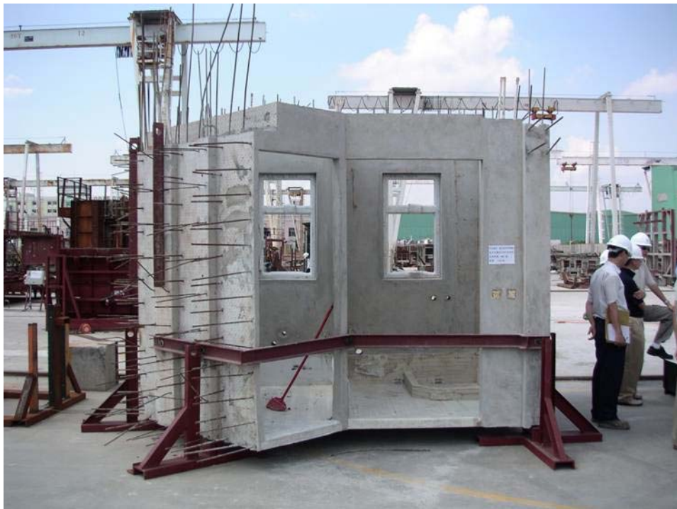
相片四：預製浴室連廚房
