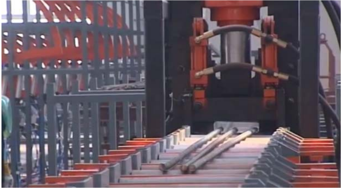
相片十五：機械化剪切及屈曲鋼筋
