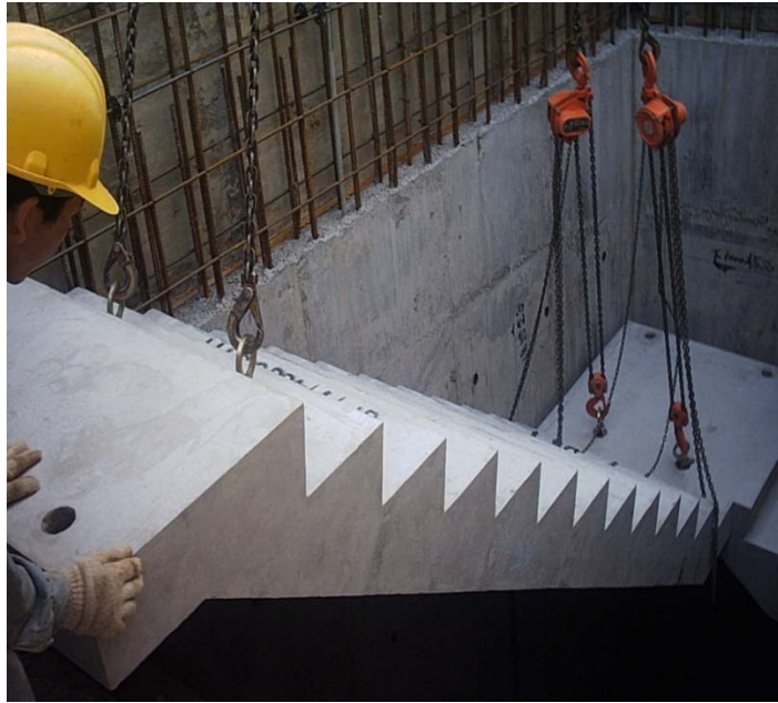
相片七：預製樓梯
