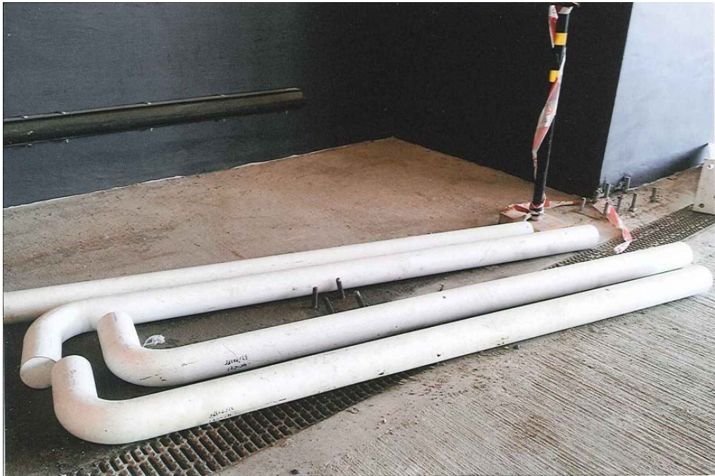
相片十九：採用專利方法安裝護欄
