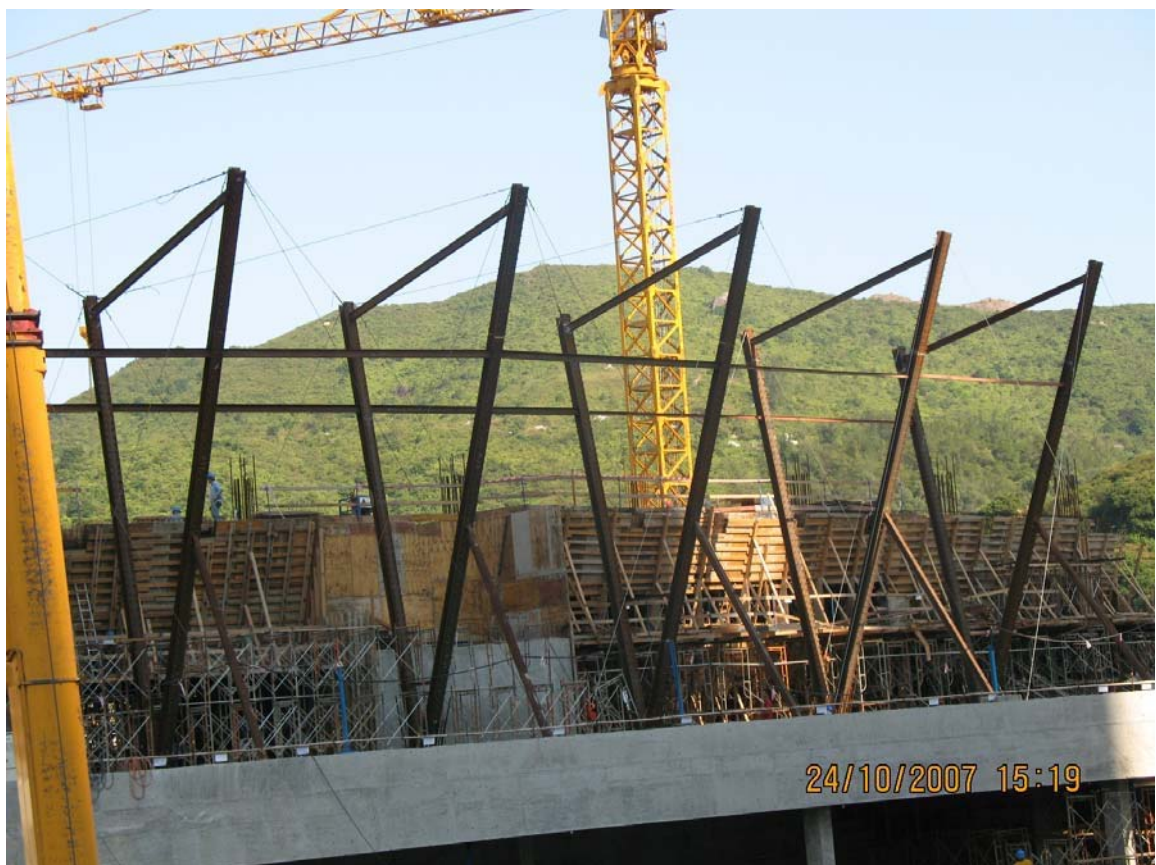
相片十：樓宇建造中的組合V型柱墩
