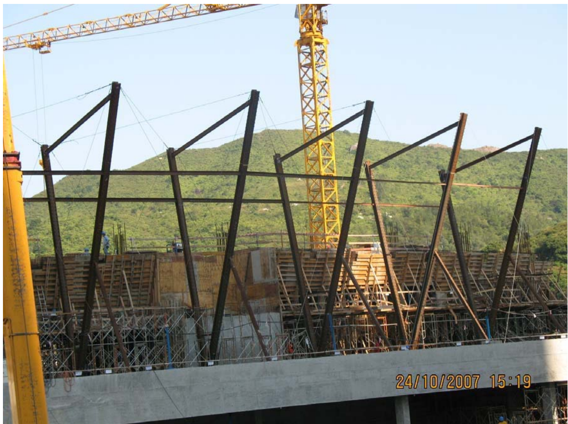
相片十：楼宇建造中的组合V型柱墩
