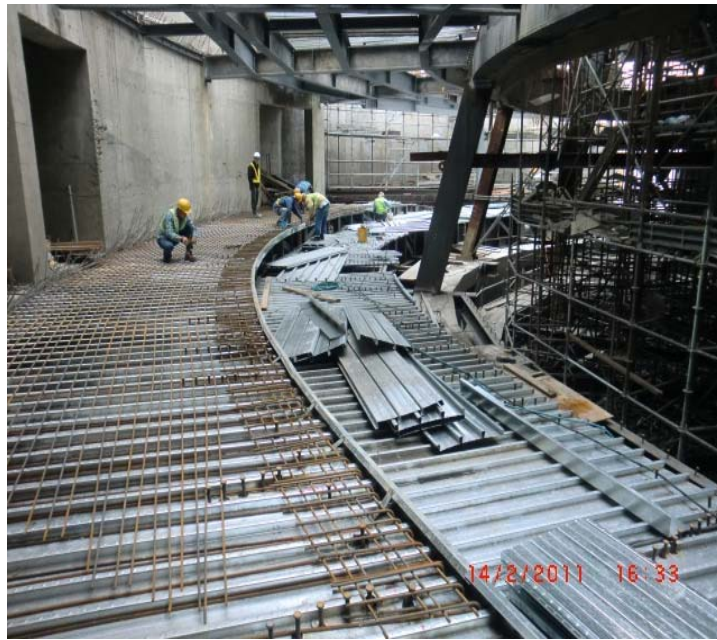
相片九：钢结构与混凝土组合楼层
