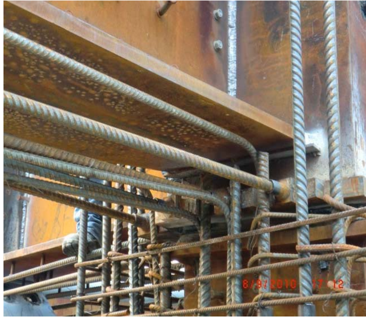
相片十一：组合结构梁柱节点
