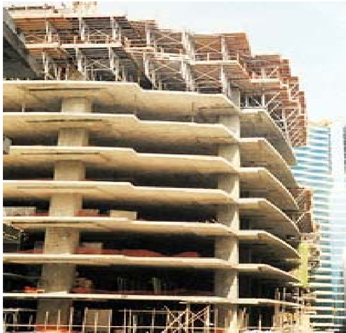
相片八：无梁楼板
