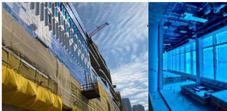
数码港第五期采用「组装合成」建筑法
