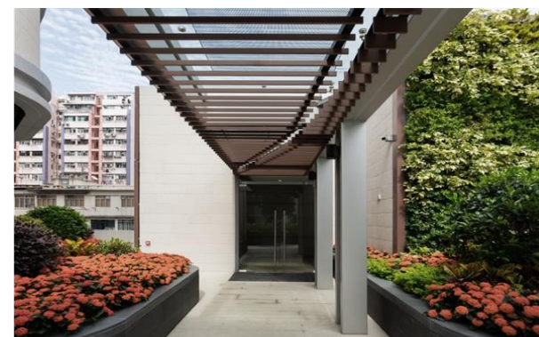
三楼有盖行人道上附设于建筑物的光伏板
