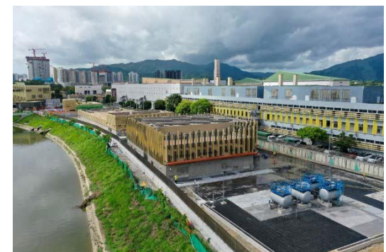
石湖墟再造水厂
