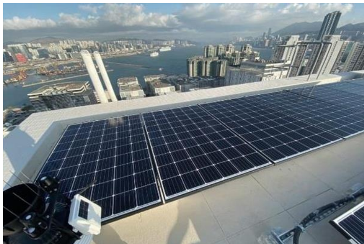
附设于住宅大楼屋顶的光伏板
