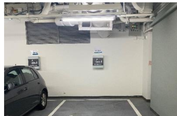
所有泊车位设置电动车充电设施
