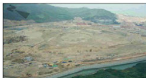
Removing Surcharge at Water Recreational Centre Area (May 2003) 水上活動中心的加載泥沙正被移去（二零零三年五月）
