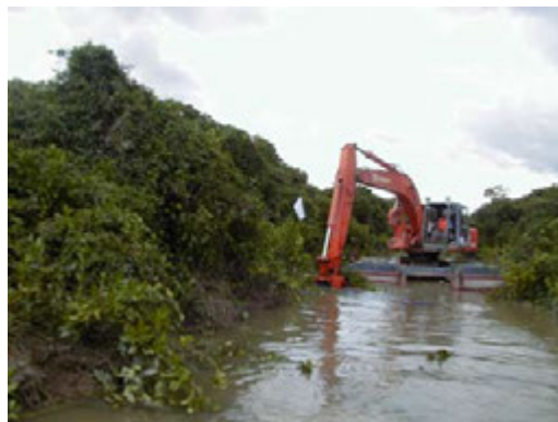
Dredging in Progress 挖掘工作進行中
