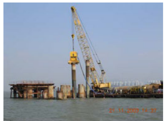
Marine Bored Piling 海上鑽孔樁工程
