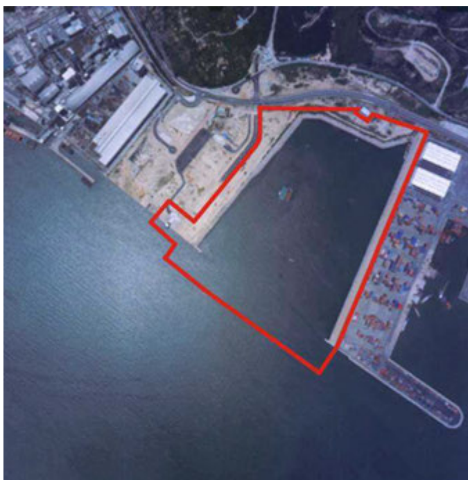
圖 1：屯門第 38 區第二期填海工程鳥瞰圖
