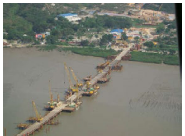
Marine piling using temporary access bridge 在臨時橋上進行海上鑽孔樁工程
