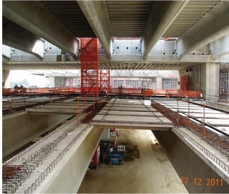
Photo 13 : Semi-precast beams
