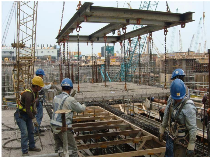
Photo 14 : Semi-precast slabs
