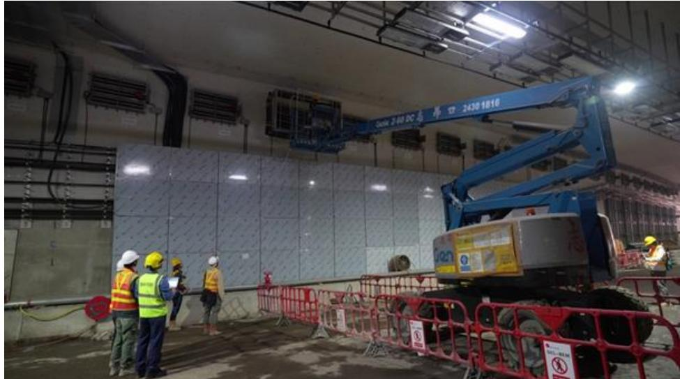
然而，消防處提出一個關鍵點：「新幹線隧道內的抽煙系統有接近800個防煙閘，驗收過程需要在每個防煙閘的多個位置量度風速，並以目測方式檢視其開關是否順暢。一般隧道的防煙閘大多數是水平安裝的，我們可利用俗稱『風罩』的設備量度其閘面風速，從而節省不少時間。但隧道內的防煙閘有100多個是垂直安裝的，礙於現時市面上並無設備可以量度垂直防煙閘的風速，量度風速工作因而需要以人手進行，過程相當費時且涉及大量人手。」
