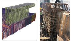
以建築信息模擬技術配合自動生產預製鋼筋組件 Automated prefabricated rebar production using Building Information Modelling
