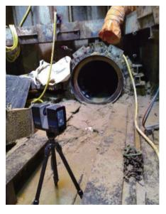
三維激光掃描儀在工地的使用情況 Use of laser scanner on site
