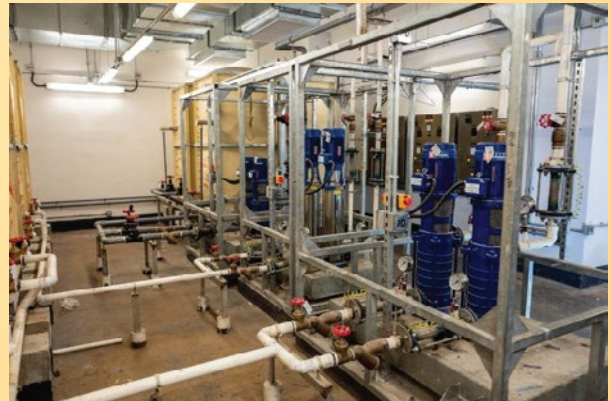
沙田富山公眾殮房重置工程 - 水泵房模組 Reprovisioning of Fu Shan Public Mortuary in Shatin - Pump Room Module
