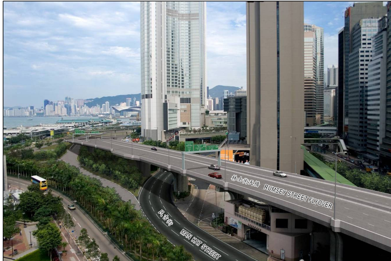
視圖 1 - 林士街天橋 VIEW 1 - RUMSEY STREET FLYOVER
