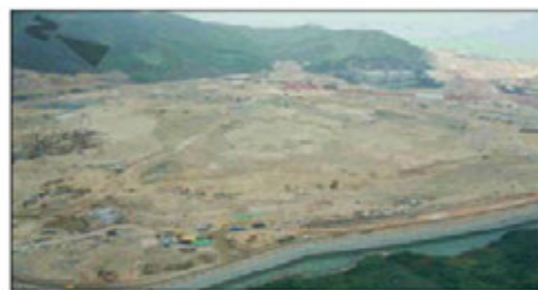
Removing Surcharge at Water Recreational Centre Area (May 2003) 水上活動中心的加載泥沙正被移去（二零零三年五月）
