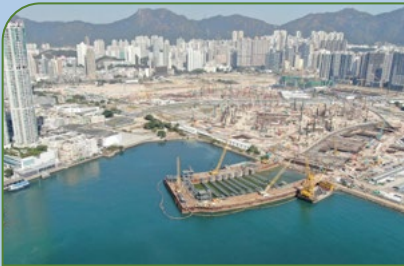
第一期中九龍幹線臨時填海 (2019年11月)
