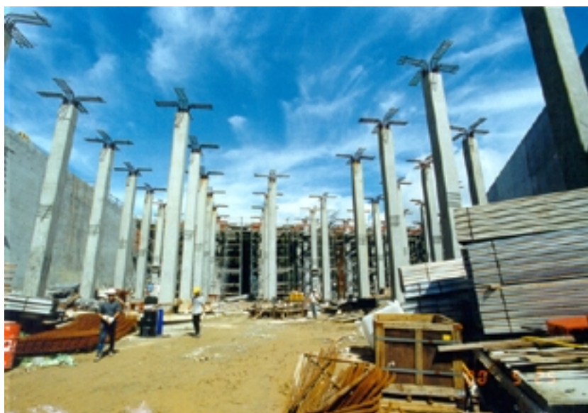
蝴蝶谷主配水庫第 I 階段工程計劃 – 興建中的間隔
